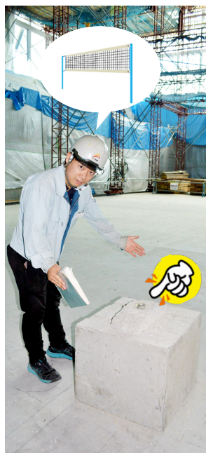
バレーボールなどの支柱を入れる基礎コンクリート
