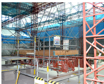
荷物をのせて昇降する作業台
