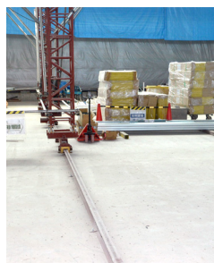
移動式足場が動くレール
