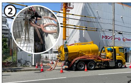
② 流動化処理土を使用しての埋戻し
