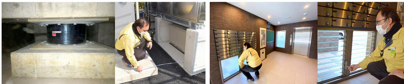
左の画像は建物地下の免震装置で、地震時には免震装置が移動するため60cmの建物間隔を空けています
